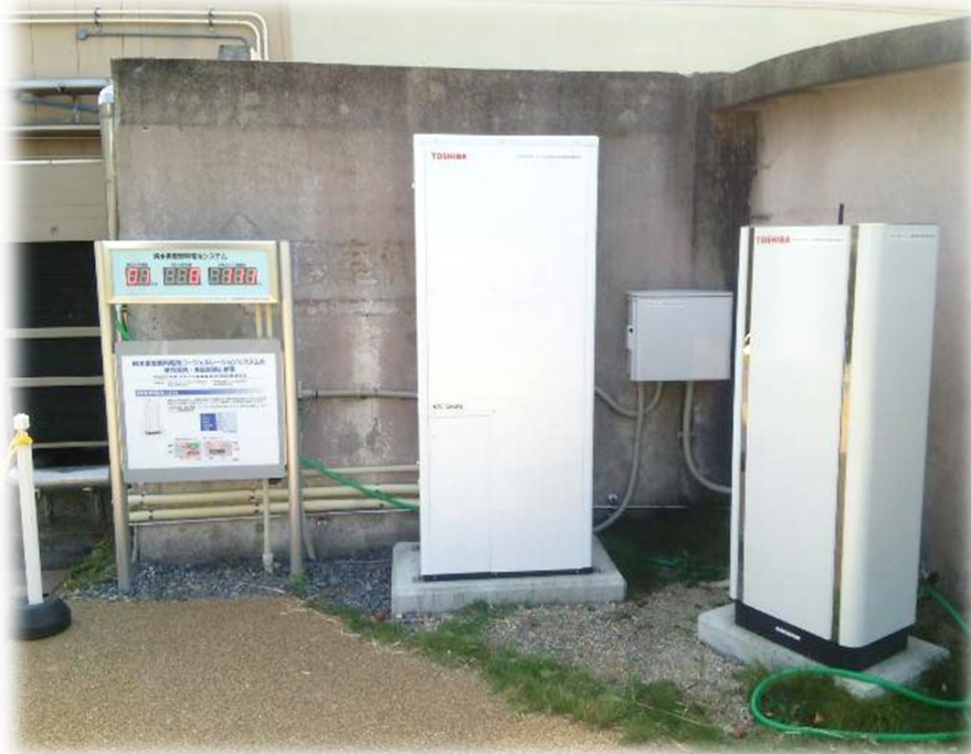
純水素ボイラー型貯湯ユニットと燃料電池ユニットを設置
