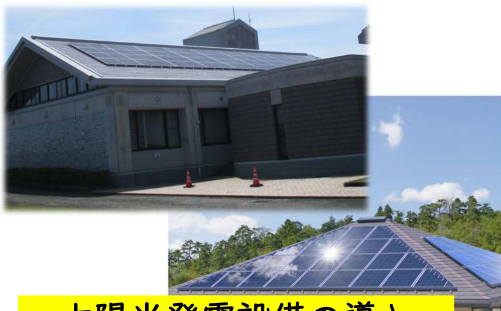
太陽光発電設備の導入
